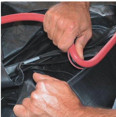
Abb.11: Anbringen des Kantenschutzes
